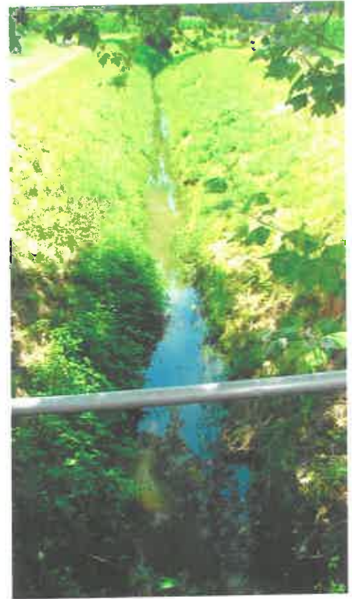
Photo n°6 : vue du pont ralentissement du courant et élargissement de la ligne d'eau
