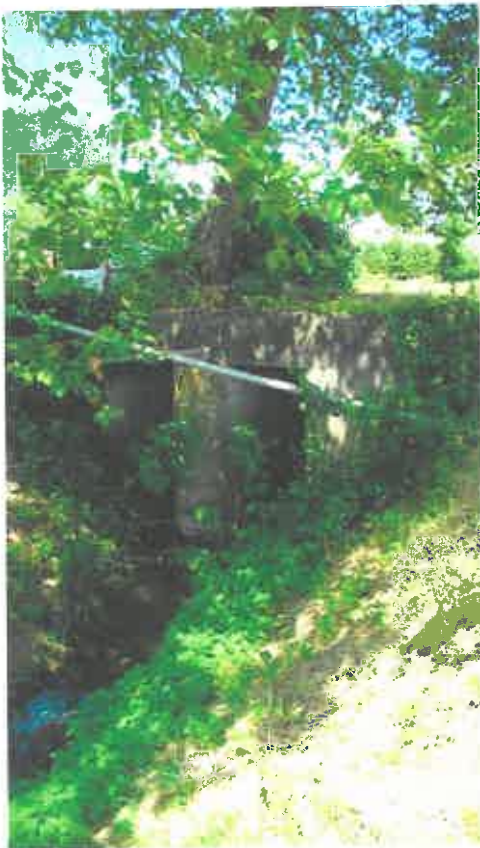
Photo n°7 : vue du pont sur le Rec
