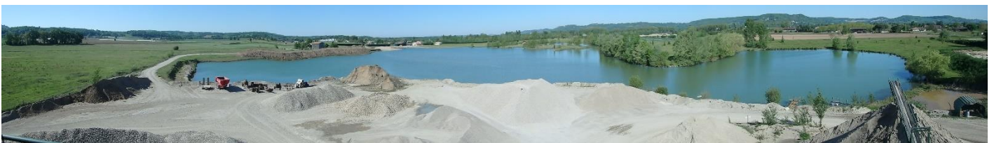
Etat actuel de la zone de mise à l'eau
